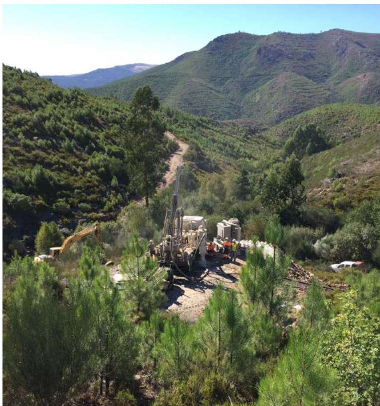
Sondagens no Pinheiro →
